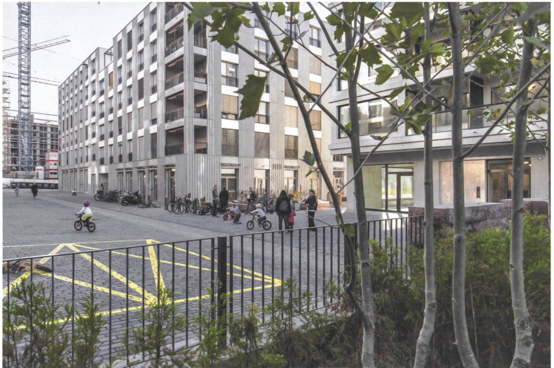
Dichte Packung: Das Wohnhaus der Genossenschaft Hofgarten besetzt das ganze Baufeld B3 Süd in der Greencity in Zürich.
