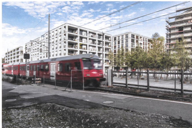
Gut erschlossen: Das Gebäude steht am Spinnereiplatz, neben dem Bahnhof Manegg.
