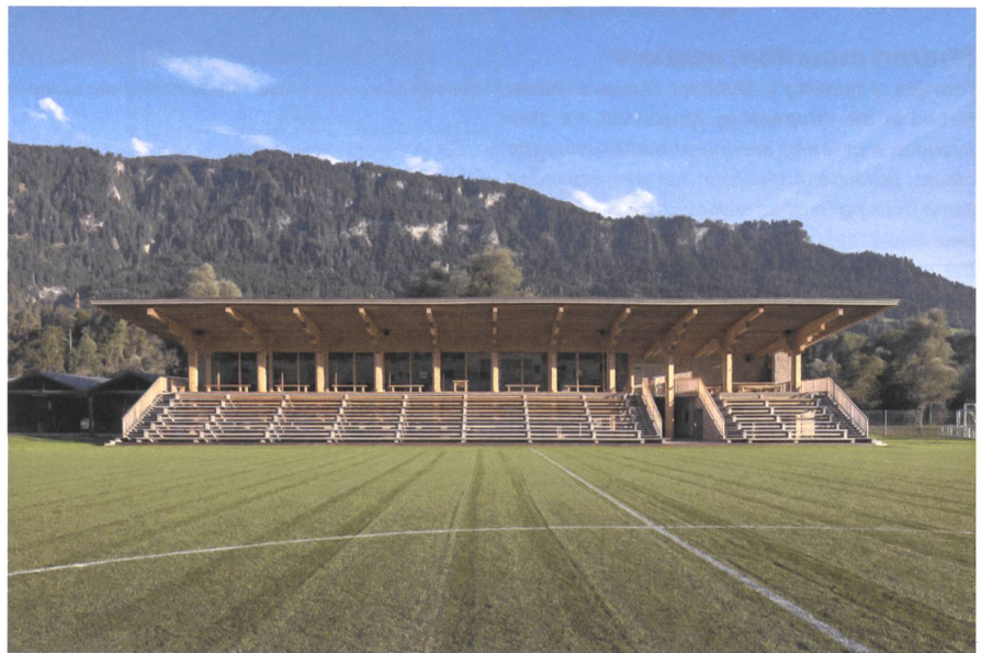
Die Tribüne wurde in 6000 Stunden Fronarbeit errichtet. | The gallery is the result of 6000 hours of voluntary work.
