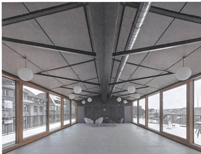
Attikageschoss: Ein dreissig Meter langer Stahlträger überspannt den Raum.
