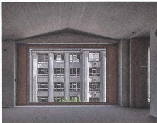
Die ein Meter dicken Decken der Treppenhäuser fangen die Schubkräfte der Faltwerke auf.
