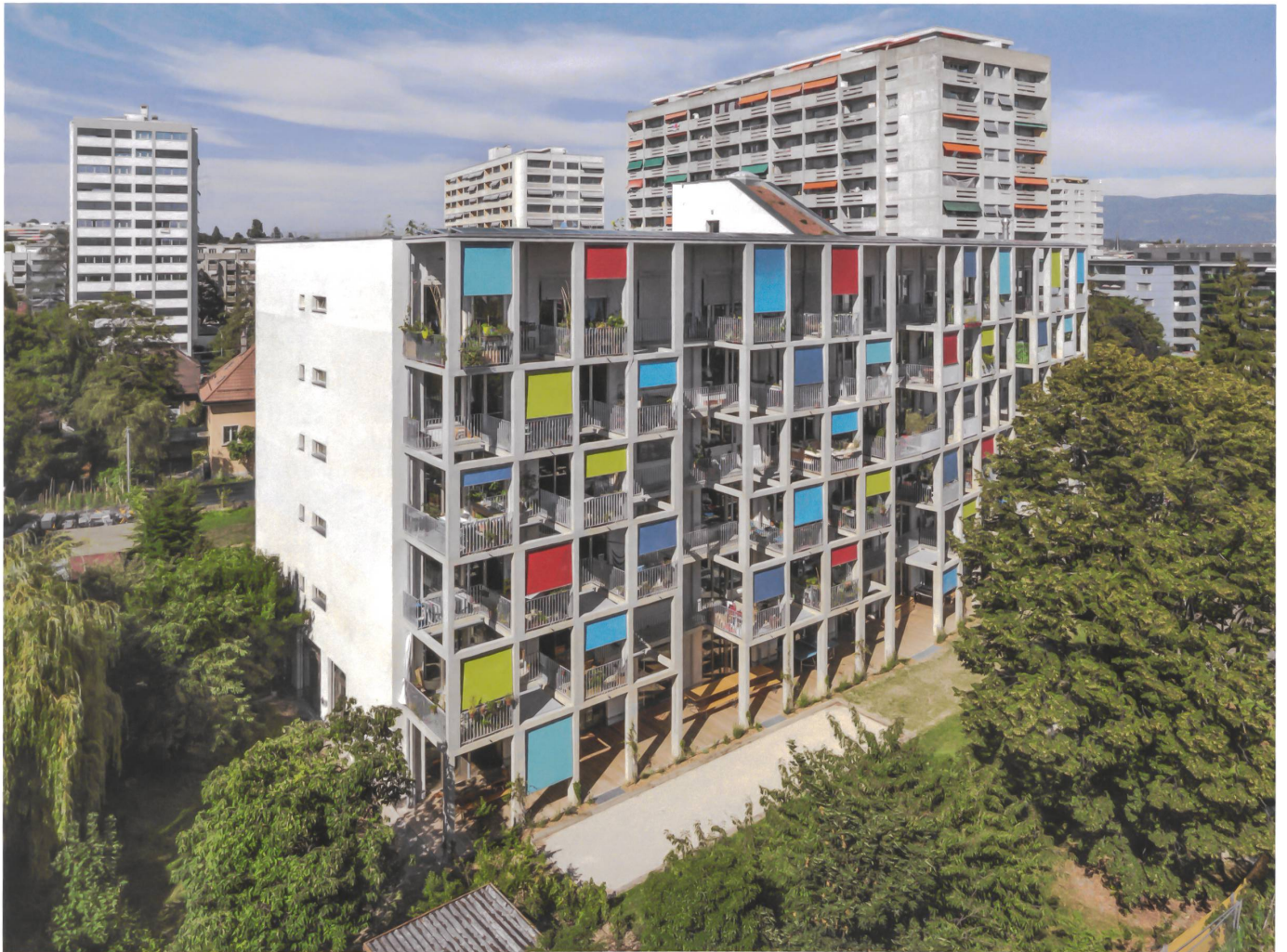
Zur Sonnenseite streckt sich die Siedlung Soubeyran in Genf mit Betonbalkonen, die über zwei Geschosse Licht und Luft hereinholen.
