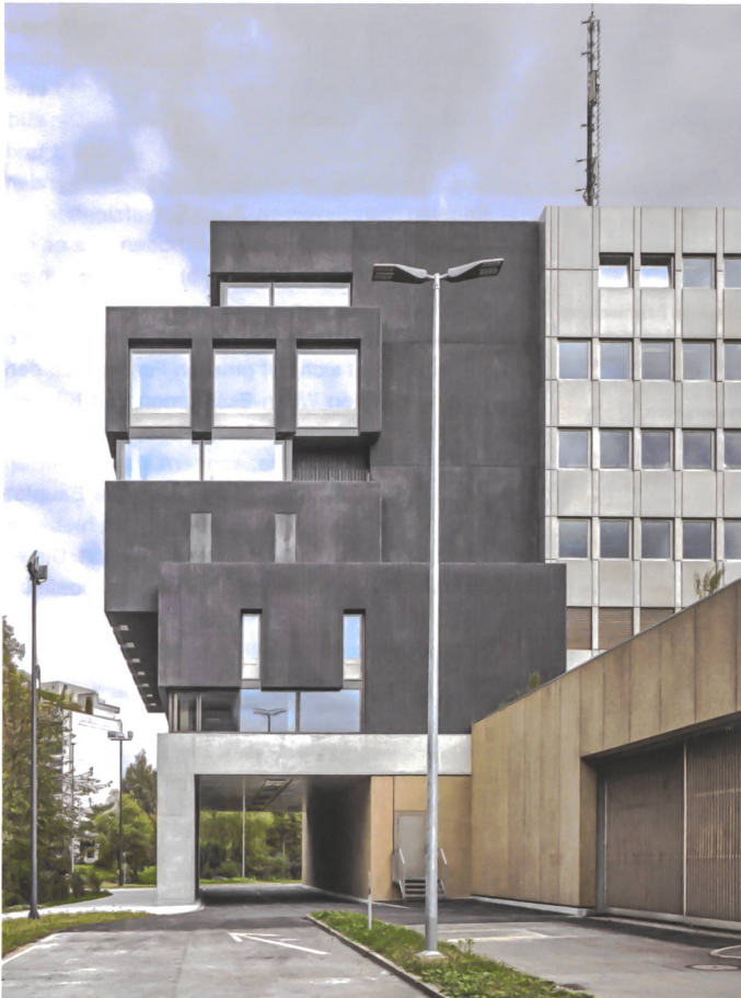
Der Anbau hebt sich selbstbewusst vom Bestand ab.
