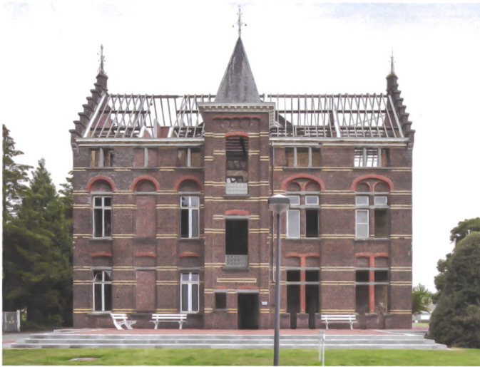
Psychiatrische Klinik Caritas in Melle: Architekten de Vylder Vinck Vaillieu (ADVVT) bauten ein Haus bis auf die Grundmauern zurück.
