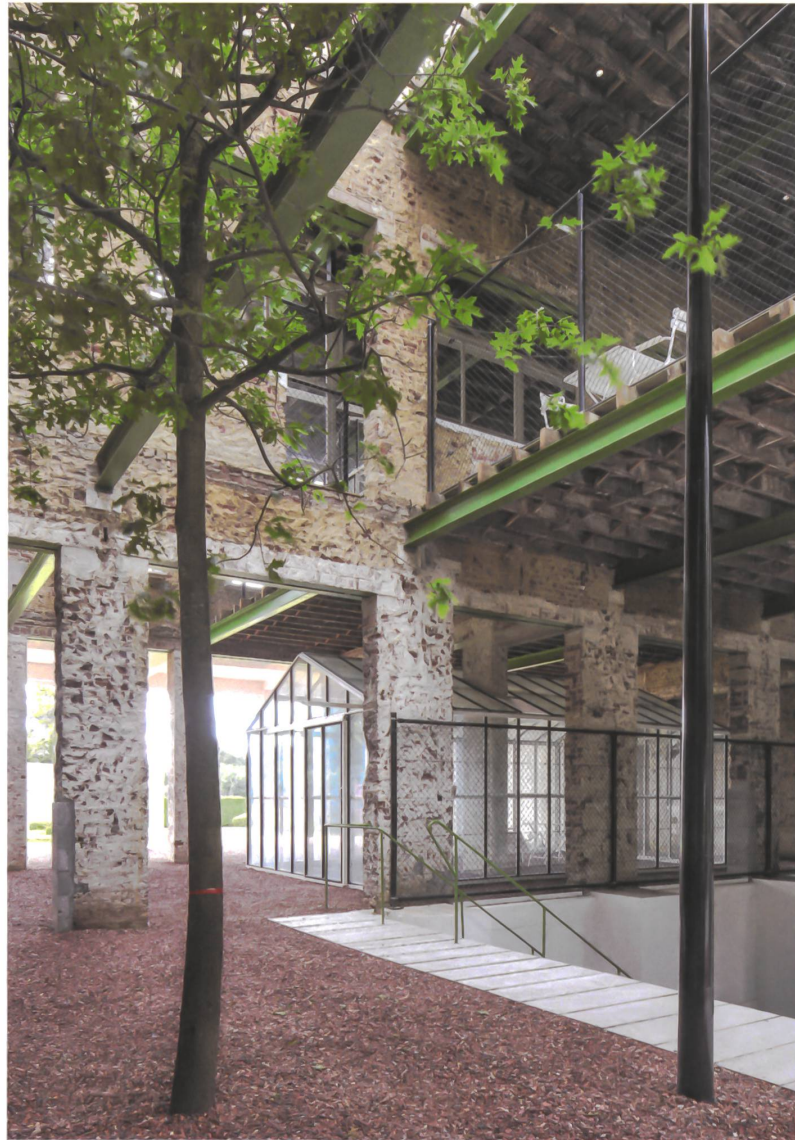
Innen ist nun aussen, mit Bäumen und Strassenlaternen darin. Das Haus als Teil des Parks.
