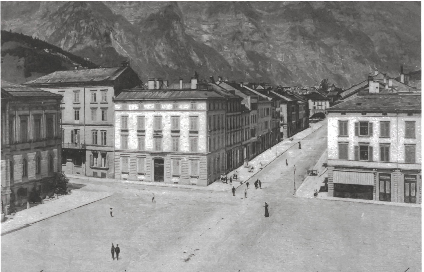
Rathausplatz, 1911: Menschen queren in freier Richtung den überaus grosszügigen, allerdings noch kahlen Raum. Dem Rathaus am linken Bildrand gehört die ganze Platzseite, was ihm eine starke räumliche Präsenz verleiht. Foto: Artist. Atelier H. Guggenheim & Co., Zürich. Digitales Bildarchiv August Berlinger, Glarus.
