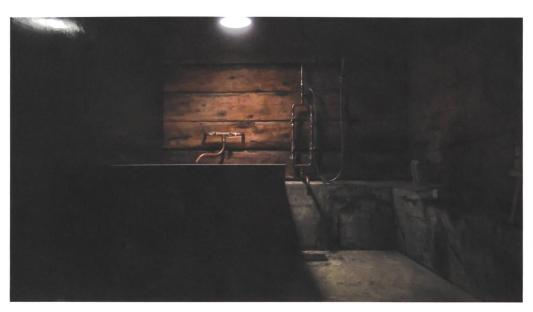
6 Der Nassbereich ist ein zweites Raummöbel aus dick und ölig grünschwarz gestrichenem Holz. Da und beim Mittelgang ist der Boden tiefer als früher. Wo die japanische Badewanne steht, bildet der Beton einen Rand. In gebogenen Kupferrohren kommt das Wasser aus den Holzbalken und fliesst im Boden ab. →
