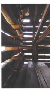
Der Stall ist ein introvertierter Ort. Vor den wenigen Fenstern laufen die ausgepflockten Holzbalken durch. So bleibt die Struktur intakt. Wer Aussicht sucht, geht spazieren. Stehen die vier Meter langen Hebefenster im Obergeschoss offen, fliesst die Aussenwelt herein: Vogelgezwitscher und Kuhgemuhe, der Duft von Heu und Mist, plaudernde Wanderer und tuckernde Traktoren.
