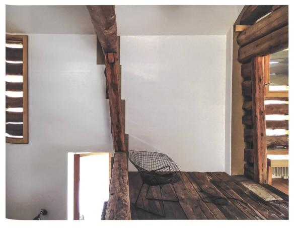
1-3 siehe Seite 22. Die Grobspanplatten sind nicht an den schiefen und unförmigen Strick angepasst, sondern versetzt gefügt. Der anfangs formbare Lehm ermöglicht die Abdichtung dank passgenauer Anschlüsse. Und die Konstruktion ist ablesbar.
