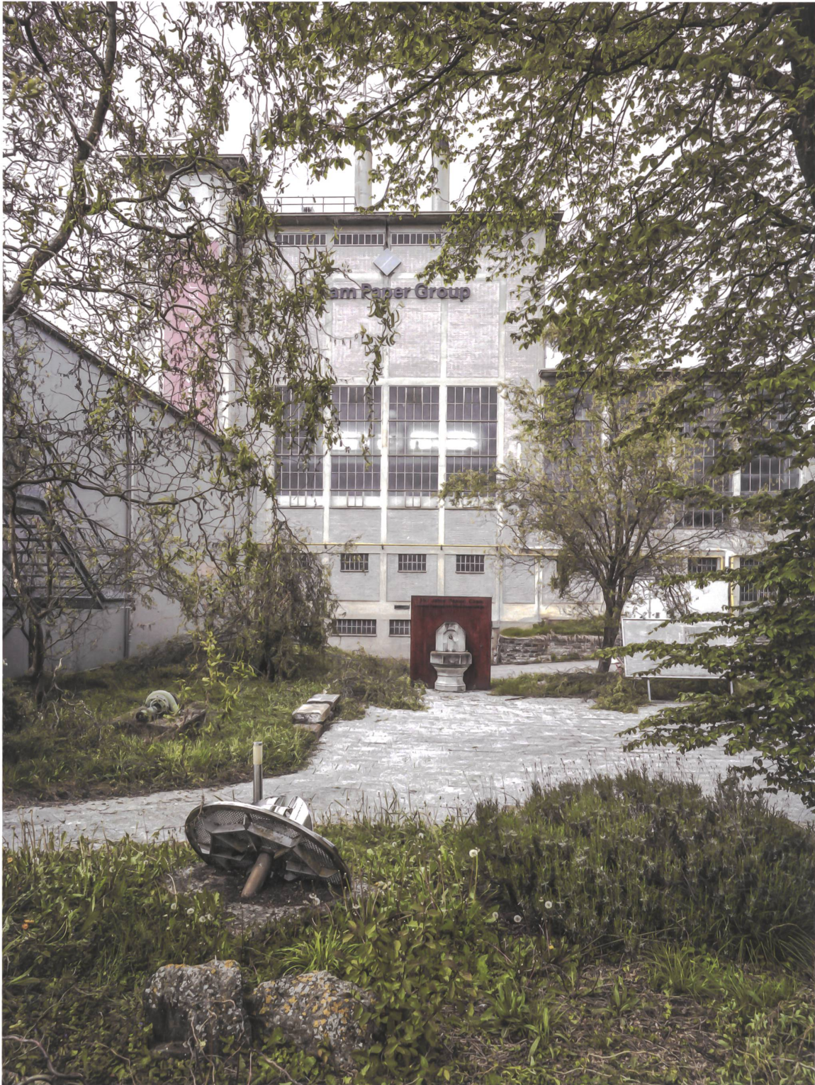
Auch zukünftig prägt das Kesselhaus aus der Nachkriegszeit das Chamer Papierl-Areal.
