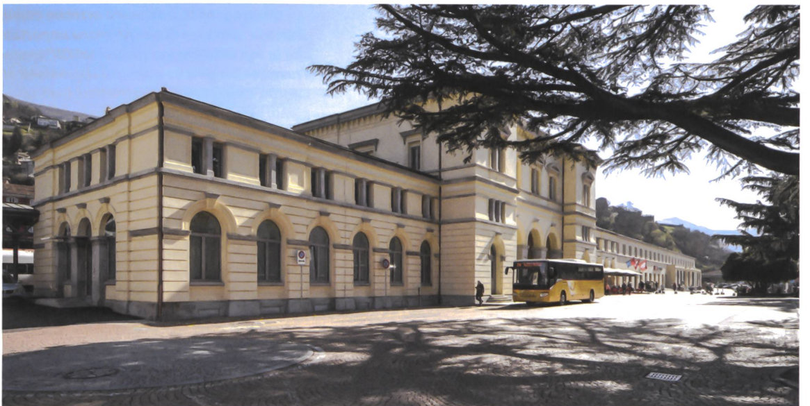
Dopo la ristrutturazione l'edificio storico di ricezione ha mantenuto il suo ruolo dominante.
