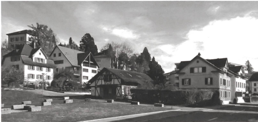
Ferrachstrasse mit Schulhaus Eschenmatt an der Hangkante.
