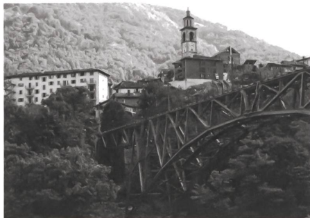
Il Ponte in ferro della «Centovallina»; ca. 1920.
