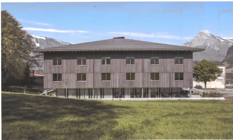
Klinik in Fläsch als grosser Stall. Der Holzeindruck täuscht, es ist Glasfaserbeton, sägeroh geschalt und eingefärbt.
