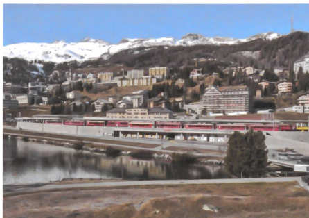
Eine mit Steinen verkleidete Betonmauer schliesst die Bahnhofsterrasse gegen den See hin ab.
