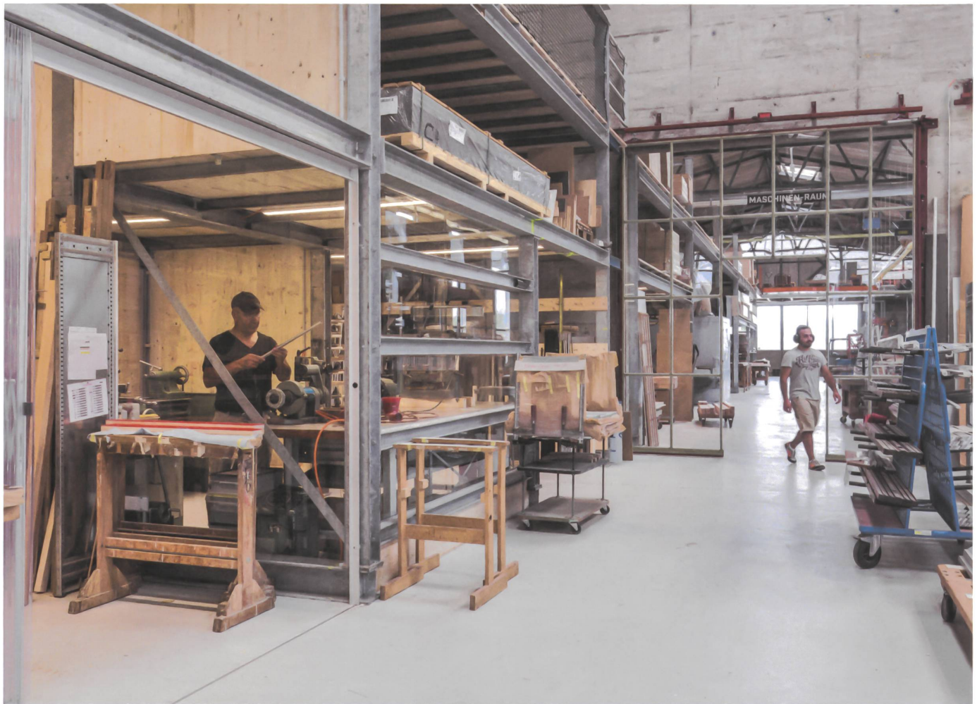
Ein Gestell des früheren Warenlagers liessen Benjamin Thut und Ralf Geckeler stehen und richteten darin die Fertigung für die beiden Produktionen von Thut und Tossa ein. Die Schiebetür in der Mitte der Halle befreiten sie von ihrem Blechkleid und füllten die Holmen mit Glas aus. So fällt der Blick durch die ganze Länge der Halle.
