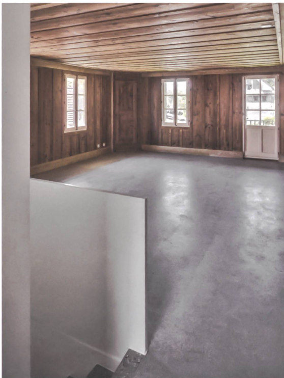
Im ehemaligen Schulhaus 1 schmückt das renovierte Täfer die Wände.
