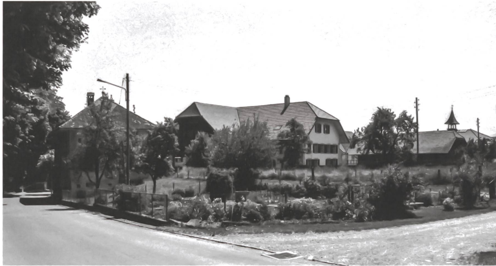
Idyllisches Ensemble: das Schulhaus 1, das grosse Bauernhaus 6 und der Schweine Stall 7 um 2005. Foto: ISOS
