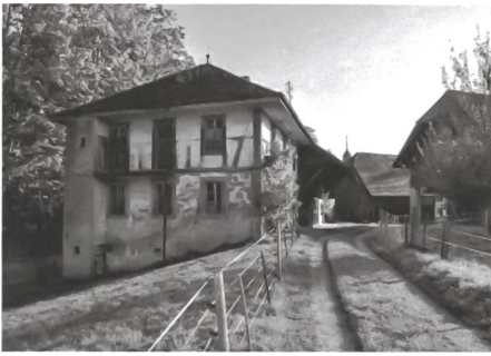
Das Schulhaus 1 war in schlechtem Zustand. Foto: Gemeinde Cressier
