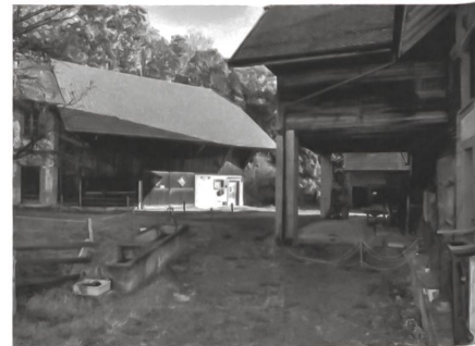
Der Platz 8 vor dem Umbau. Foto: Gemeinde Cressier
