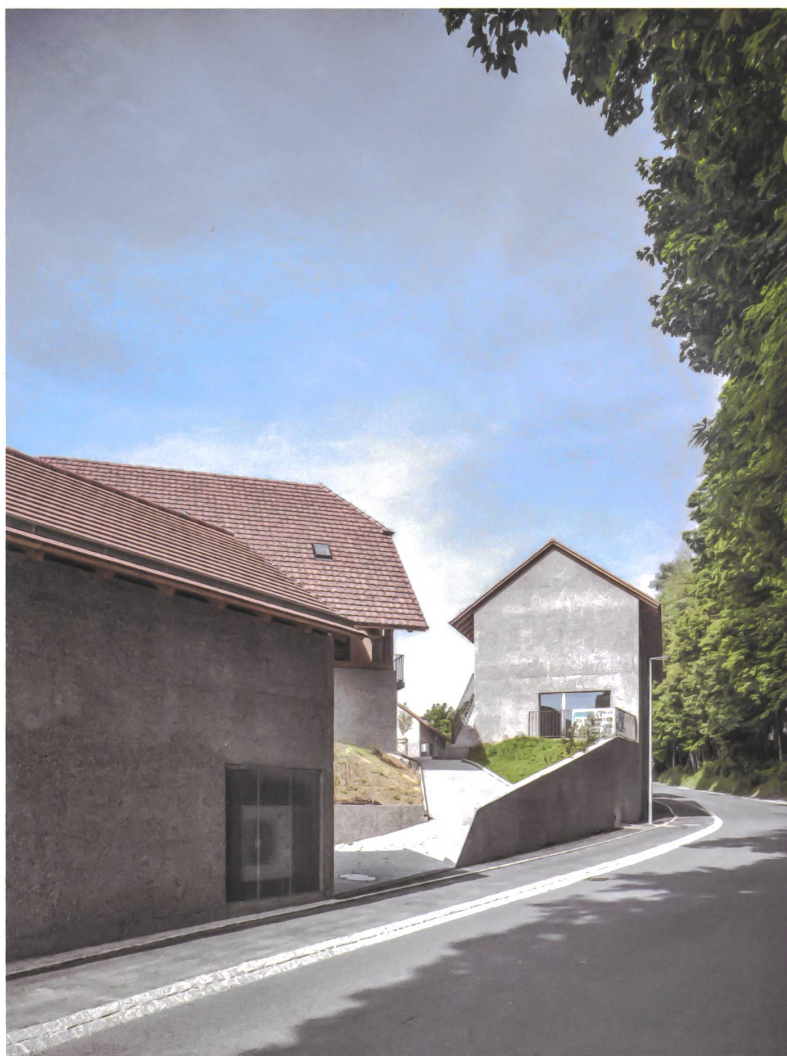
An der Strasse bauten LVPH Architectes eine Totenkapelle 4, von der ein Weg zum Dorfplatz führt.
