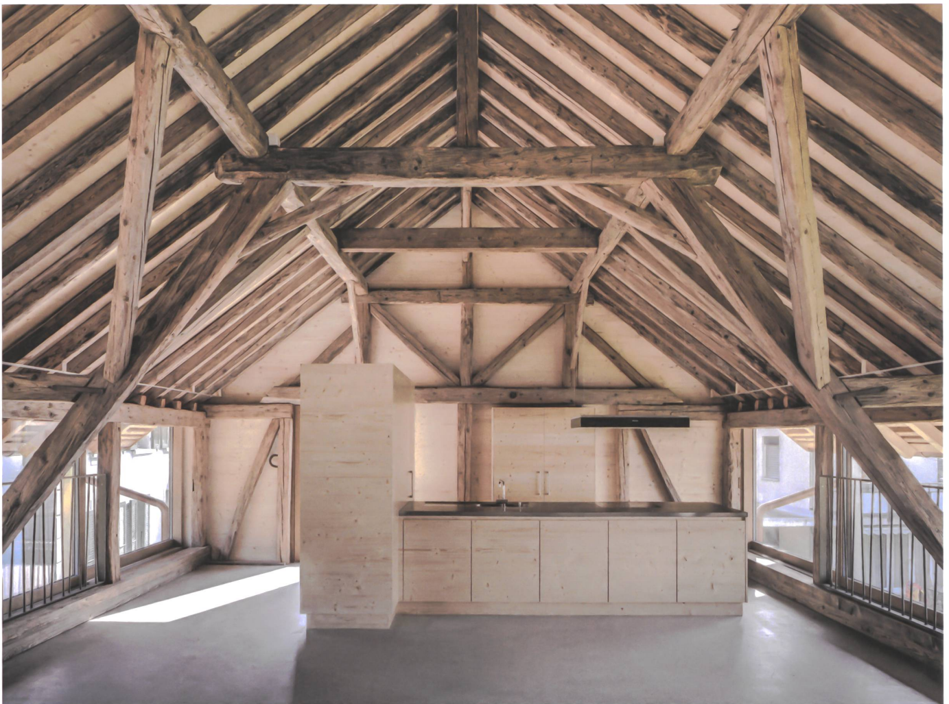
Aussen haben die Architekten den Schweinestall 6 mit Isolation eingepackt, Innen prägt das alte Gebälk den Raum überraschend.
