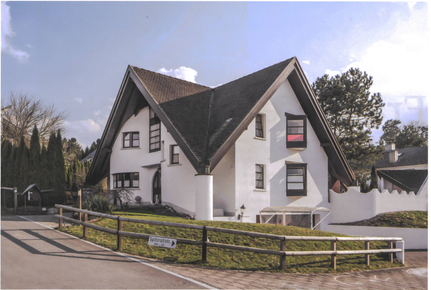
Viel Platz für wenig Bewohner: Frauenfelder Einfamilienhaus.
