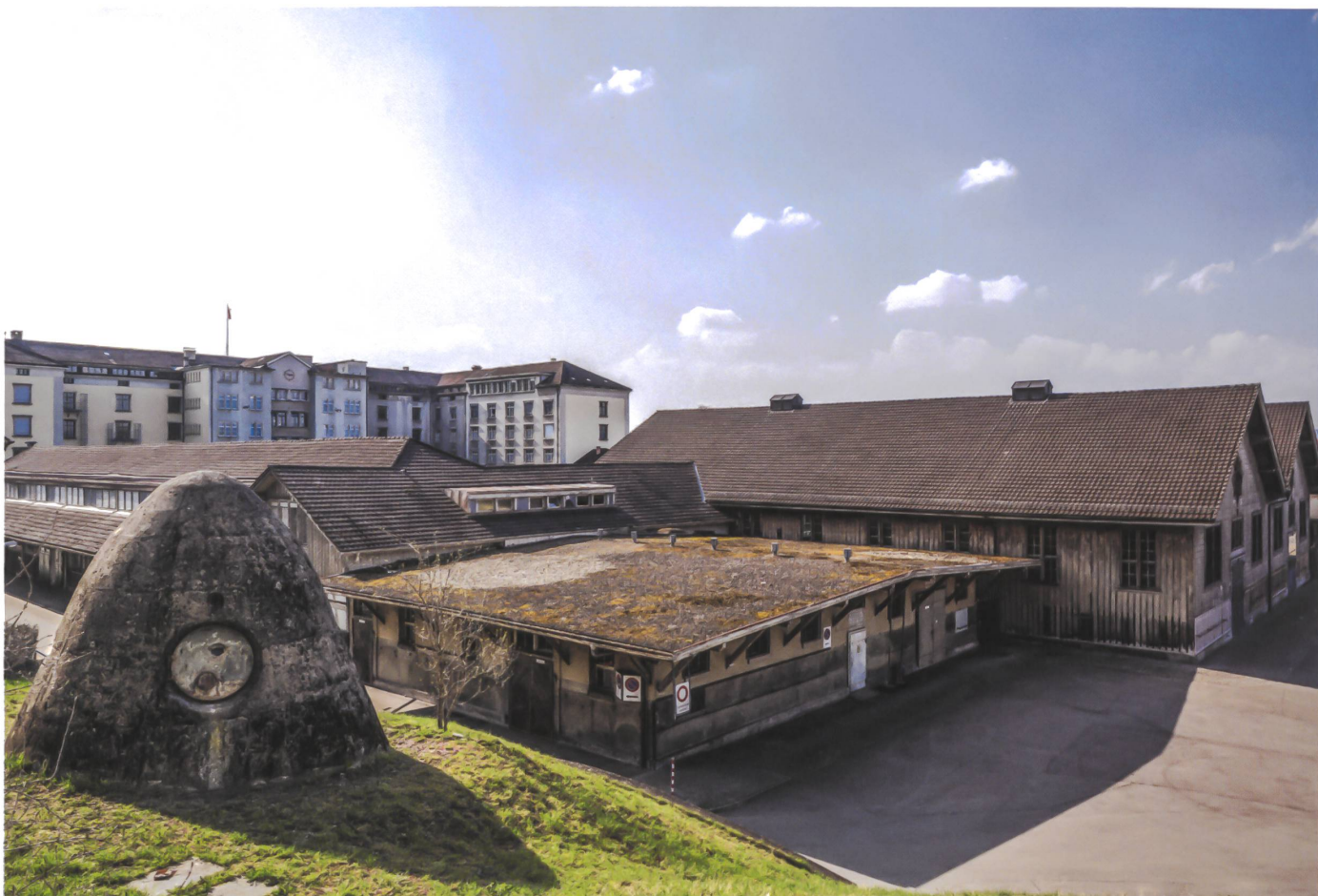
Der Blick von der Terrasse aus: Die Gebäude der Stadtkaserne sollen weitgehend erhalten bleiben.
