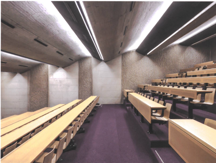
Erstklassige Akustik in den neuen Hörsälen des Universitätsspitals Lausanne: Die Geometrie der Decke und der Seitenwände lässt den Schall dank glatter und rauer Oberflächen schneller oder langsamer fließen.
