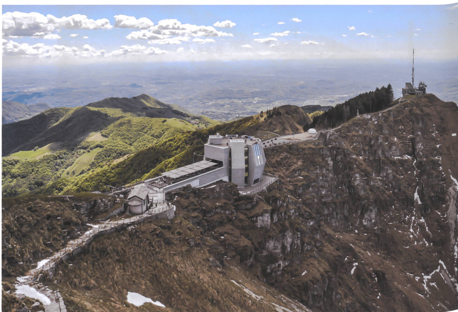
Das punktsymmetrische Gebäude ruht auf dem Grat, der die Situation und die Aussicht zweiteilt.
