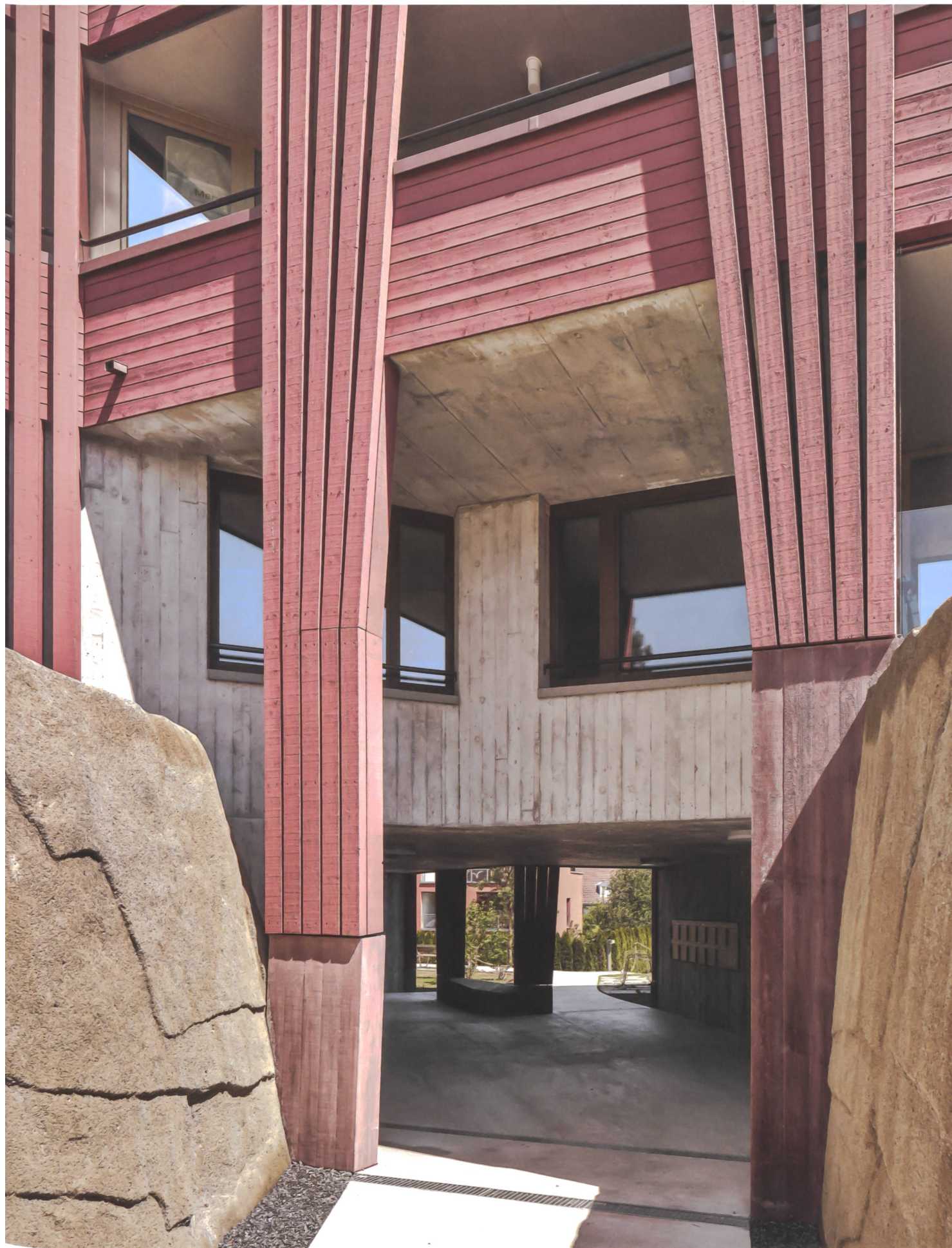
Neudorfstrasse in Wädenswil: Zwischen unbeholfenen Kunstfelsen führt der Weg zur Gebäudedetaille, die Fassade zieht sich wie ein Vorhang zur Seite. Foto: Roland Bernath
