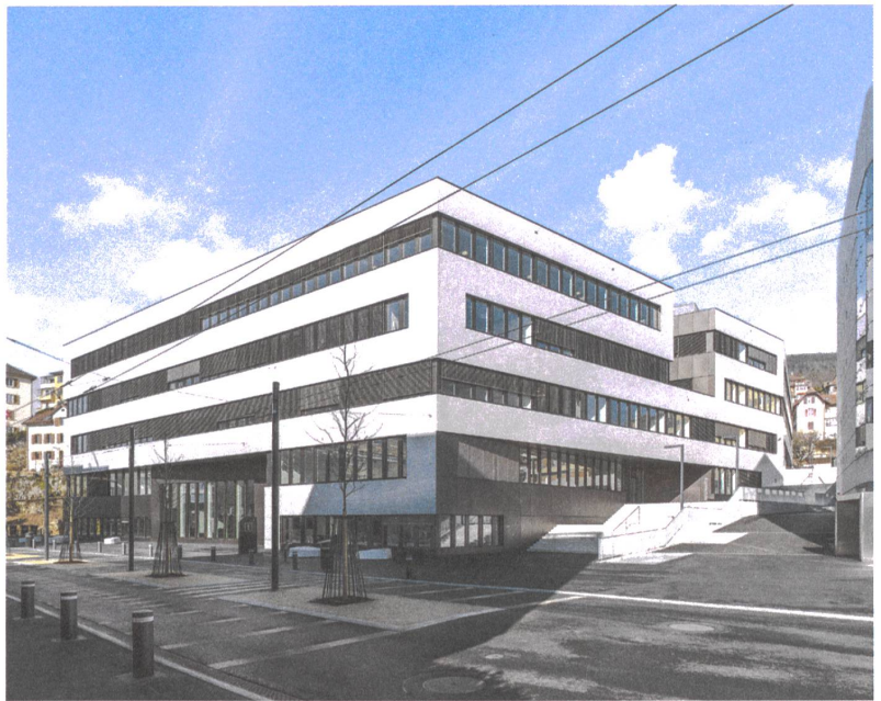
1 Dem Lehr- und Forschungsgebäude in Neuenburg ist der Systembau nicht anzusehen. | On ne devine pas la construction modulaire du bâtiment d'enseignement et de recherche de Neuchâtel.
