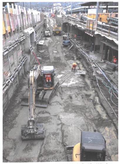
Bauphase 2: Das neue Gleis 8 ist schon in Betrieb rechts. Auf einer Inselbaustelle entstehen die Quartierverbindung, die Personenunterführung Mitte und der neue Mittelperron der Gleise 6 und 7.
