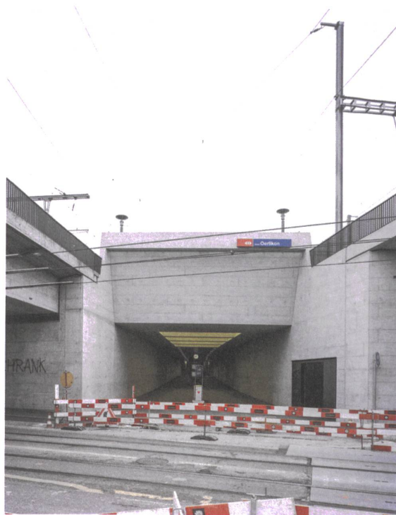
Die Schranken werden fallen: Nach dem Bau des Andreasturms und mit der Entwicklung von Leutschenbach wird dies einer der wichtigen Bahnhofszugänge sein.
