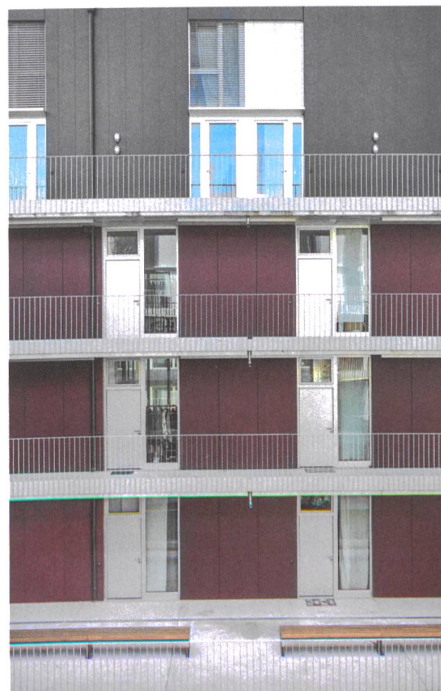
Laubengänge umfassen den Hof, Fenster gewähren Ein- und Ausblick in die Wohnungen. Je nach Lage ist auch die Tür transparent oder nicht.
