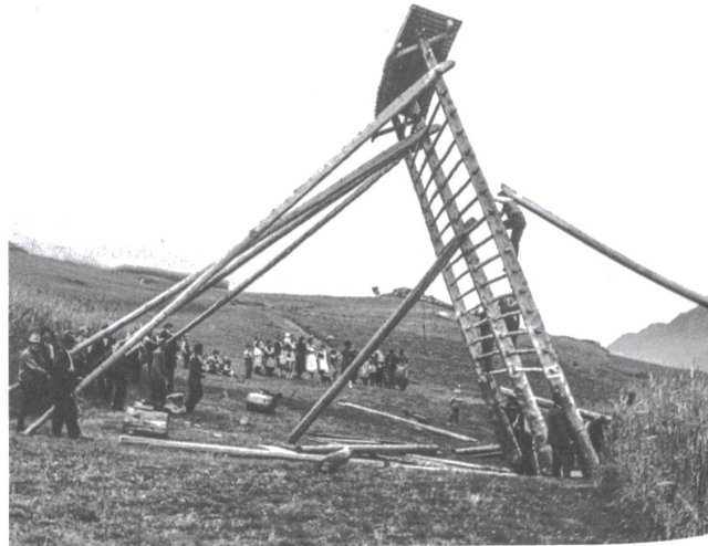
Aufrichten einer Kornhiste in Mompé-Tujetsch (1938). Foto: Alfons Maissen
