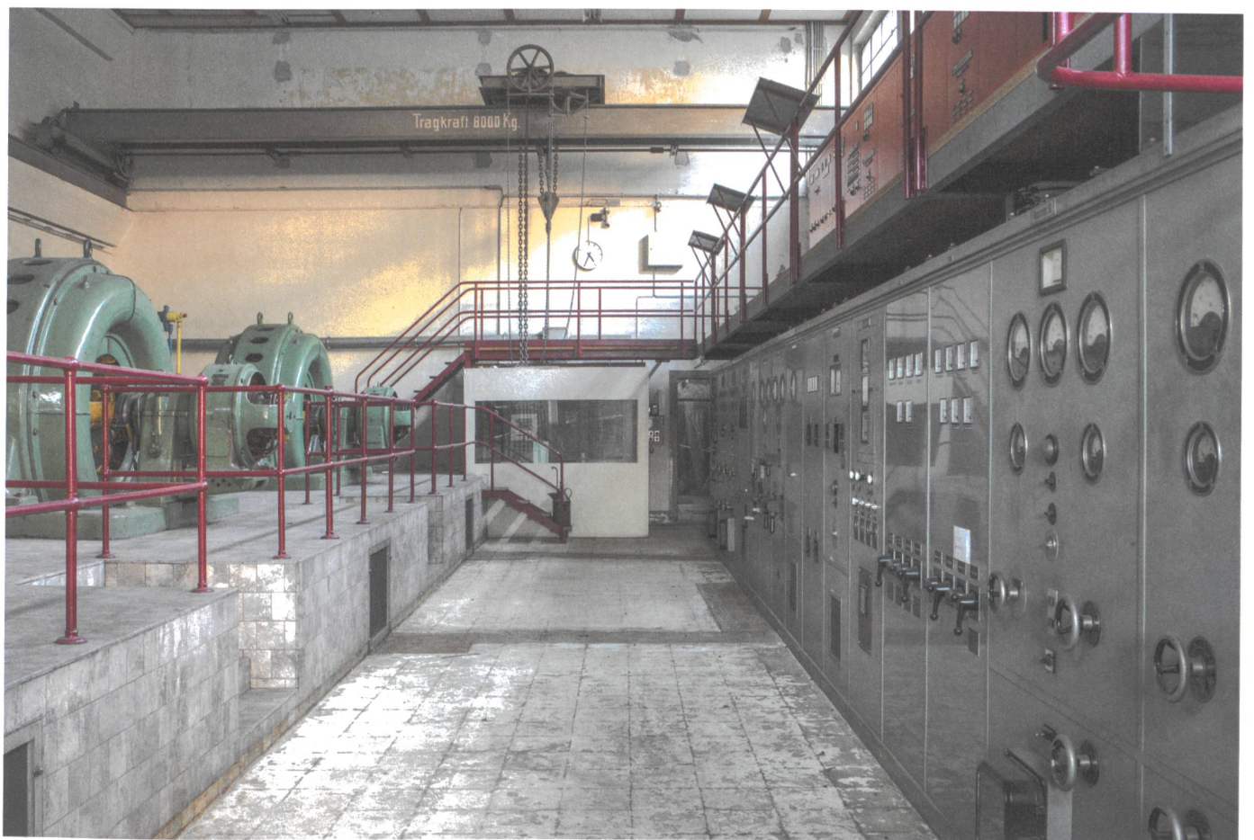
Im ehemaligen Turbinenraum des Melser Fabrikkraftwerks wird ein Restaurant eingerichtet.
