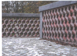
Ein Ziegelornament schmückt die Brüstungen.
