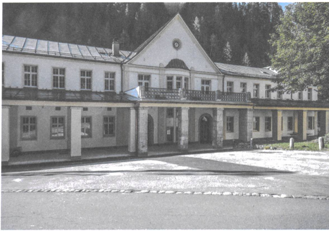
Nairs empfängt mit der abgebrochenen, unterfangenen, wiederaufgebauten Laube.
