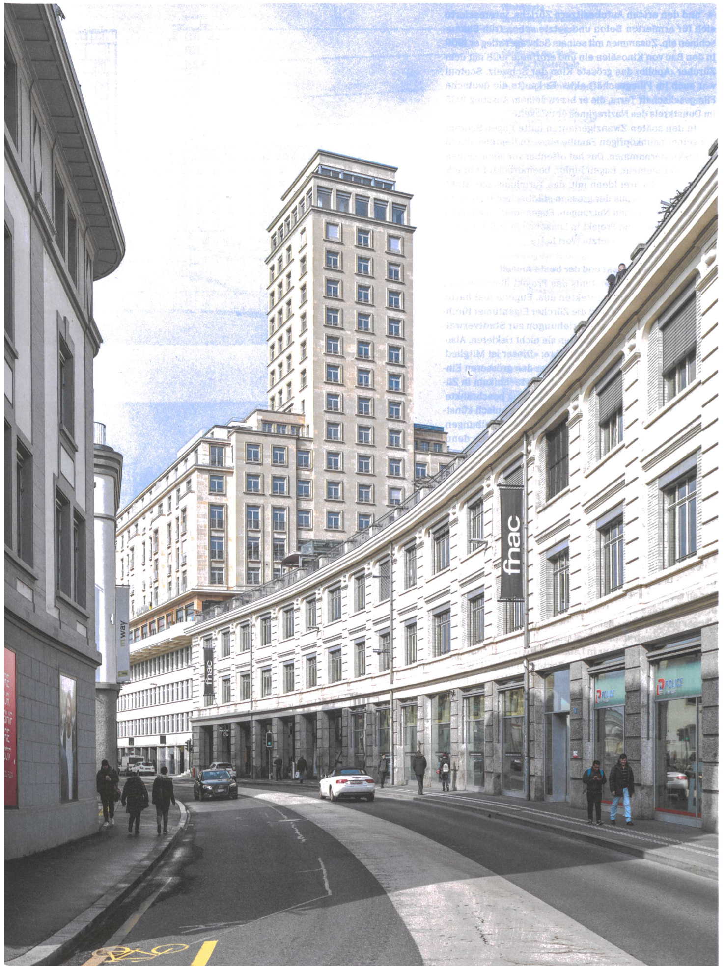
Sanliertes Wahrzeichen von 1932: das mit Naturstein verkleidete Wohn- und Geschäftshaus Bel-Air Métropole in Lausanne. Foto: Cédric Widmer
