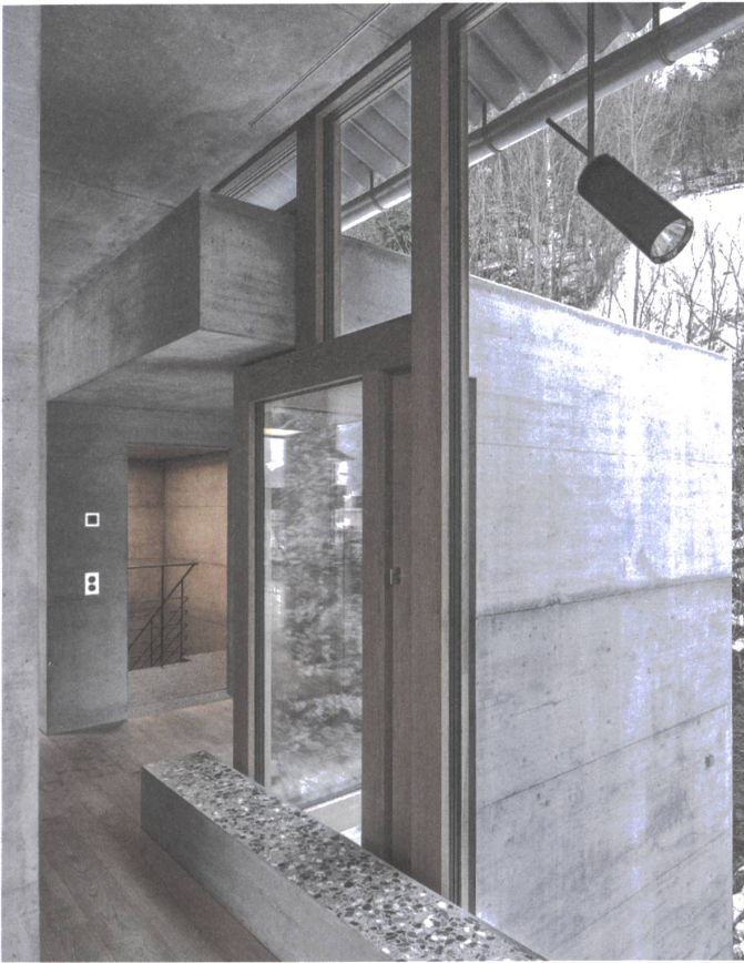
Der Aufzugsschacht schiebt sich unter die Decke, die innere Betonbank vor die Holz-Glas-Fassade. Peter Zumthors Kunst der Fuge.
