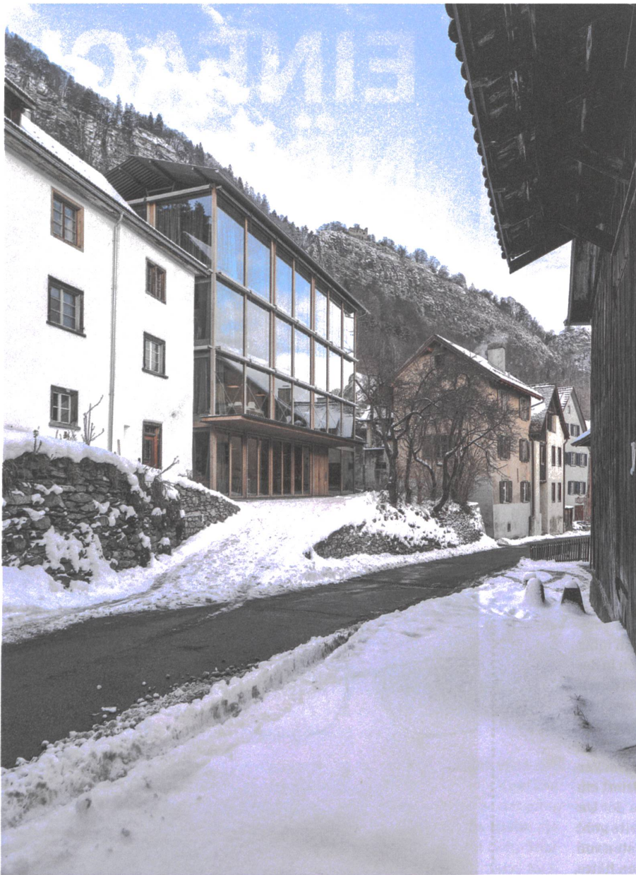
Ein Haus aus Glas und trotzdem kein Fremdkörper im Dorf: Peter Zumthors drittes Atelierhaus in Haldenstein.
