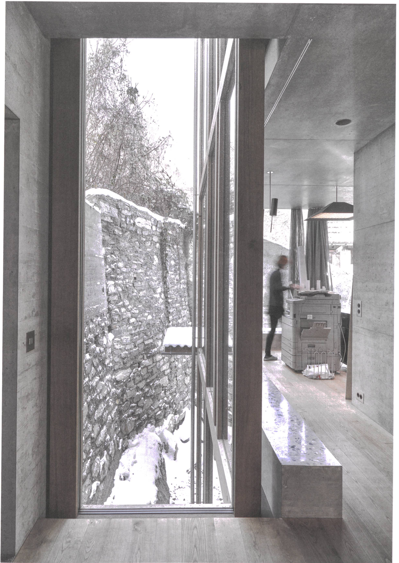
Bis auf wenige Meter schiebt sich der Neubau an eine Stützmauer heran. Vorher diente diese einer Stallscheune als hintere Aussenmauer.
