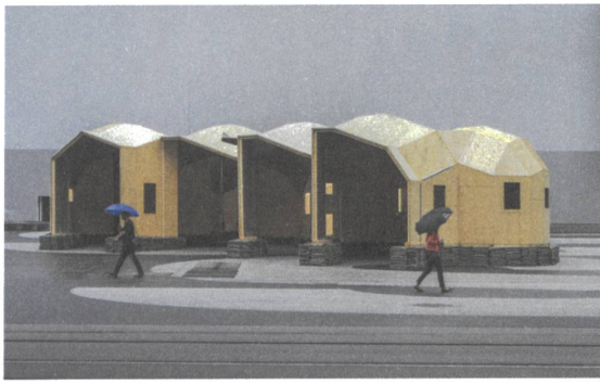
Die hölzernen Iglus des Künstlers Oscar Tuazon für die Art Basel 2016 hat der Roboter des Holzbauers Erne hergestellt. Foto: Stefan Altenburger
