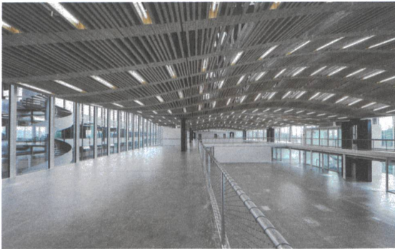
Das Holzdach des Arch-Tec-Labs der ETH Zürich wurde zu 99 Prozent digital gefertigt, verkündete die Hochschule stolz. Fotos: Andrea Diglas
