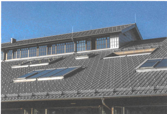
Auf dem komplett neuen Dach sitzt die aus Stahl konstruierte Dachlaterne.
