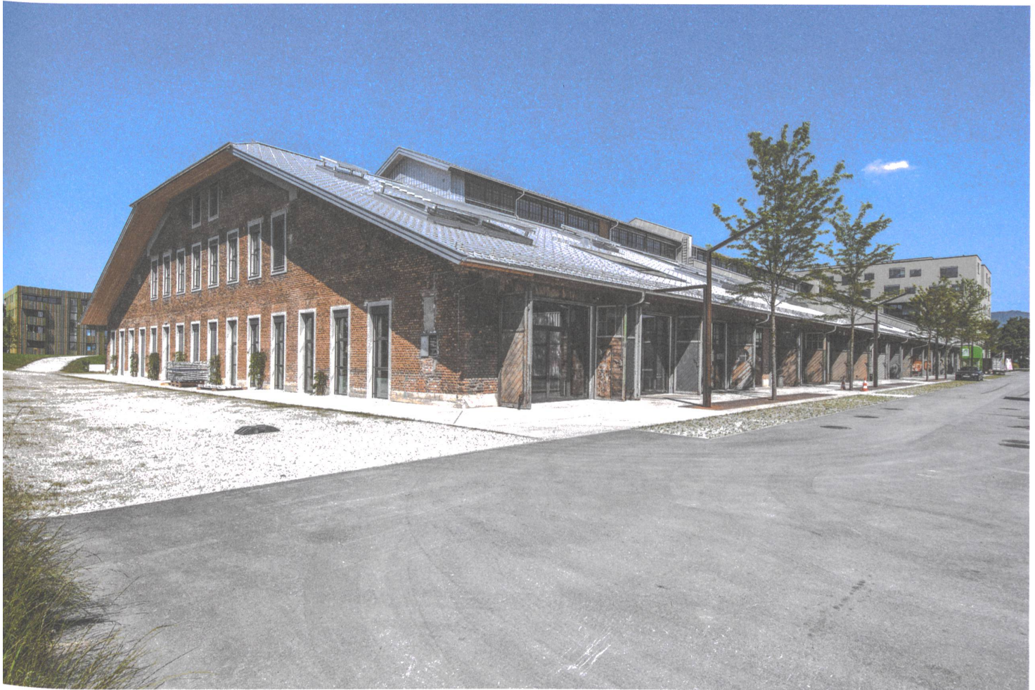
Flach und breit: Die 1939 errichtete Werkhalle ist in ein quirliges Kreativzentrum umgenutzt worden. Über vierzig neue Dachfenster und Loggias lassen viel Licht ins Innere dringen.
