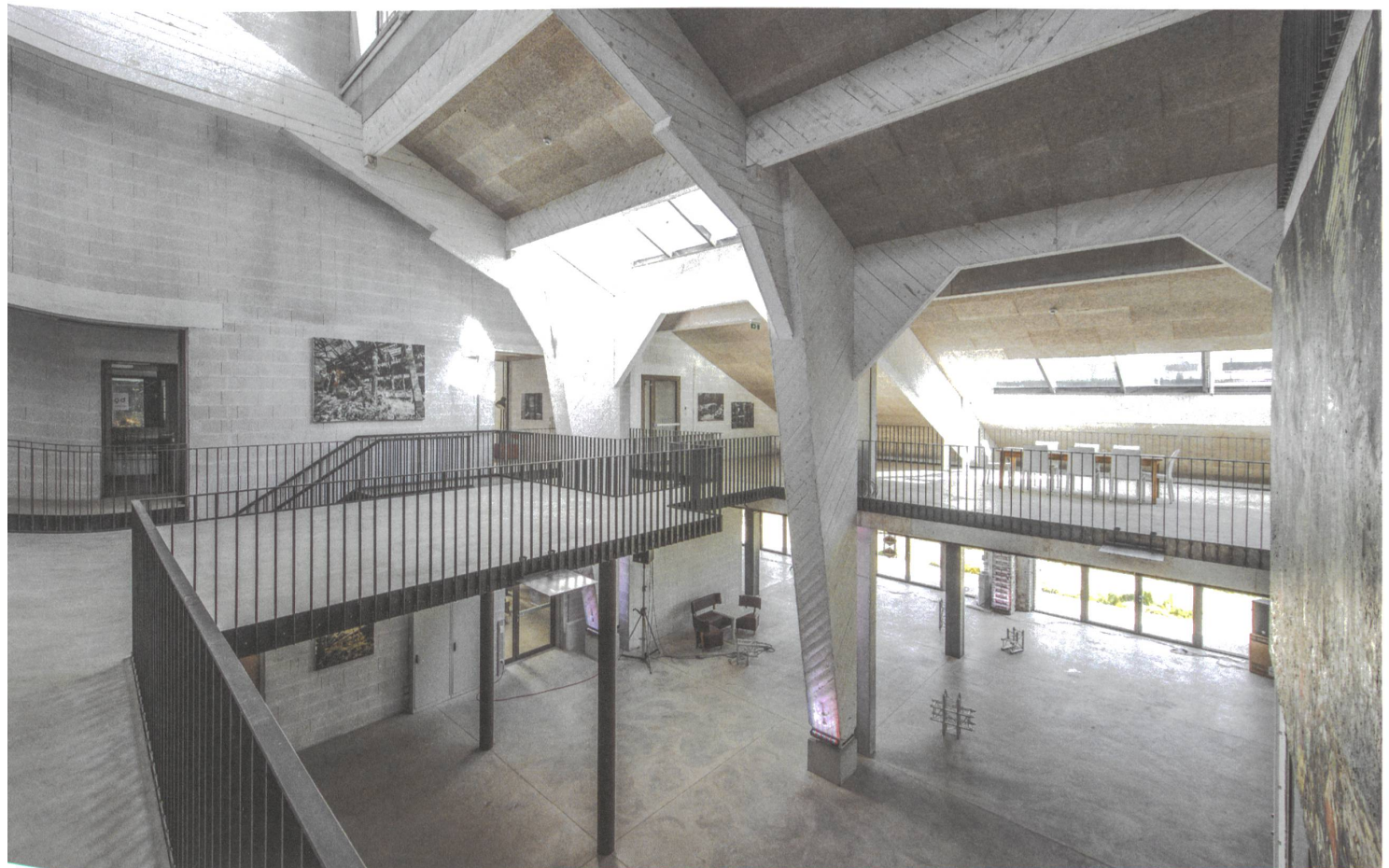
Zurückhaltende Einbauten: Dachfenster, neue Ebenen aus Beton, gesichert mit Stahlgeländern, machen aus der Panzerhalle eine luftige Denkwerkstatt.
