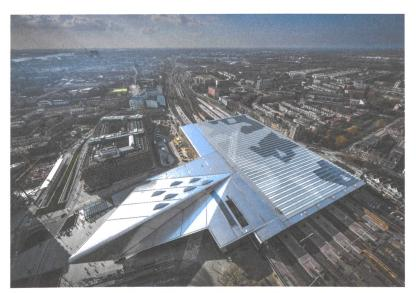
Das Faltendach markiert den Haupteingang, das gläserne (Gewächshaus) deckt die Bahnsteighalle. 130 000 Solarpaneele sind zu einem dunklen, unregelmässigen Muster im Glasdach angeordnet.
