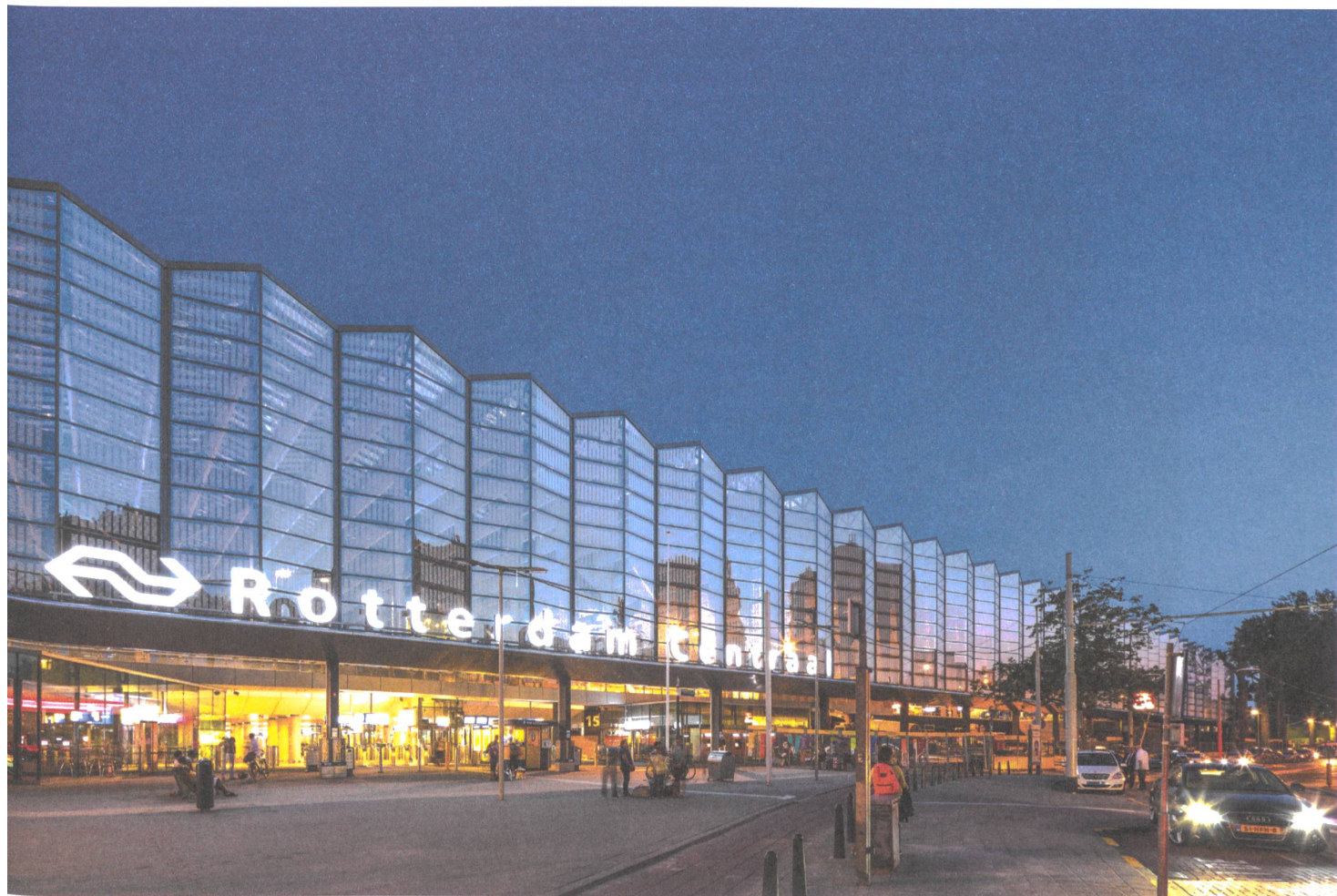
Das Nordportal ist klar die Rückseite des neuen Bahnhofs. Das Faltendach der Bahnsteighalle geht hier in die Vertikale über.
