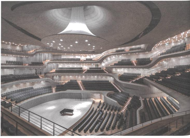
Die Haut des Konzertsaals besteht aus 10 000 computergesteuert gefrästen Gipsfaserplatten, die den Schall perfekt verteilen.
