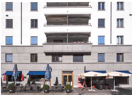
Erd- und erstes Obergeschoss sind in der Fassade zu einem Sockel zusammengefasst.
