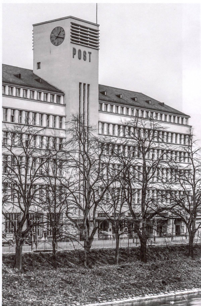
Um 1930: die modernste Post Europas Das historische Foto zeigt, dass der Turm etwas dunkler gestrichen ist als der Hauptbaukörper. Der Unterschied ist jedoch minim. Dunkel sind hingegen das Zifferblatt der Uhr sowie der Schriftzug. Die Leuchtschrift besteht aus Leuchtstoffröhren, die auf Blechbuchstaben montiert sind. Ein Fahnenmast setzt einen feinen Akzent. Foto: Baugeschichtliches Archiv der Stadt Zürich
