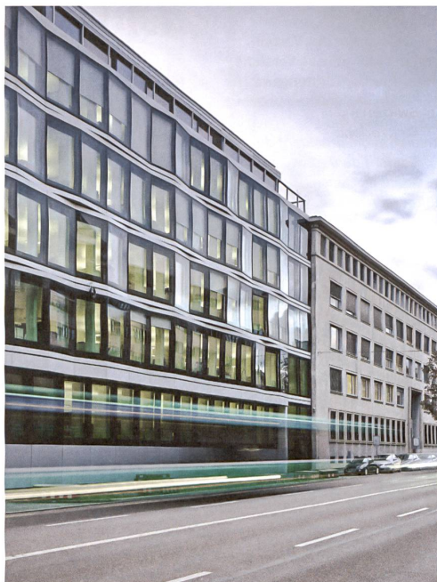
Glas- und Steinbau setzen sich gegenseitig in Szene. | Le bâtiment en pierre et celui en verre se valorisent réciproquement.
