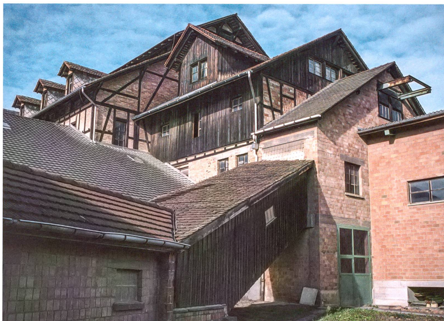
Ziegelei Berg, ein denkmalpflegerisch bedeutendes Ensemble. Fotos: Katalin Deér
