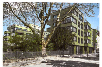
Wohnüberbauung Lukashof, Zürich Beat Rothen Architektur
