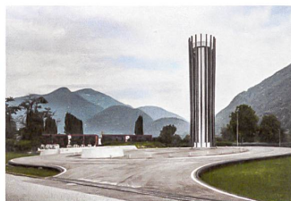
ERL Centrale Termica, Losone Buzzi studio d'architettura
