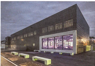
Unterwerk Zürich-Oerlikon Illiz Architektur
