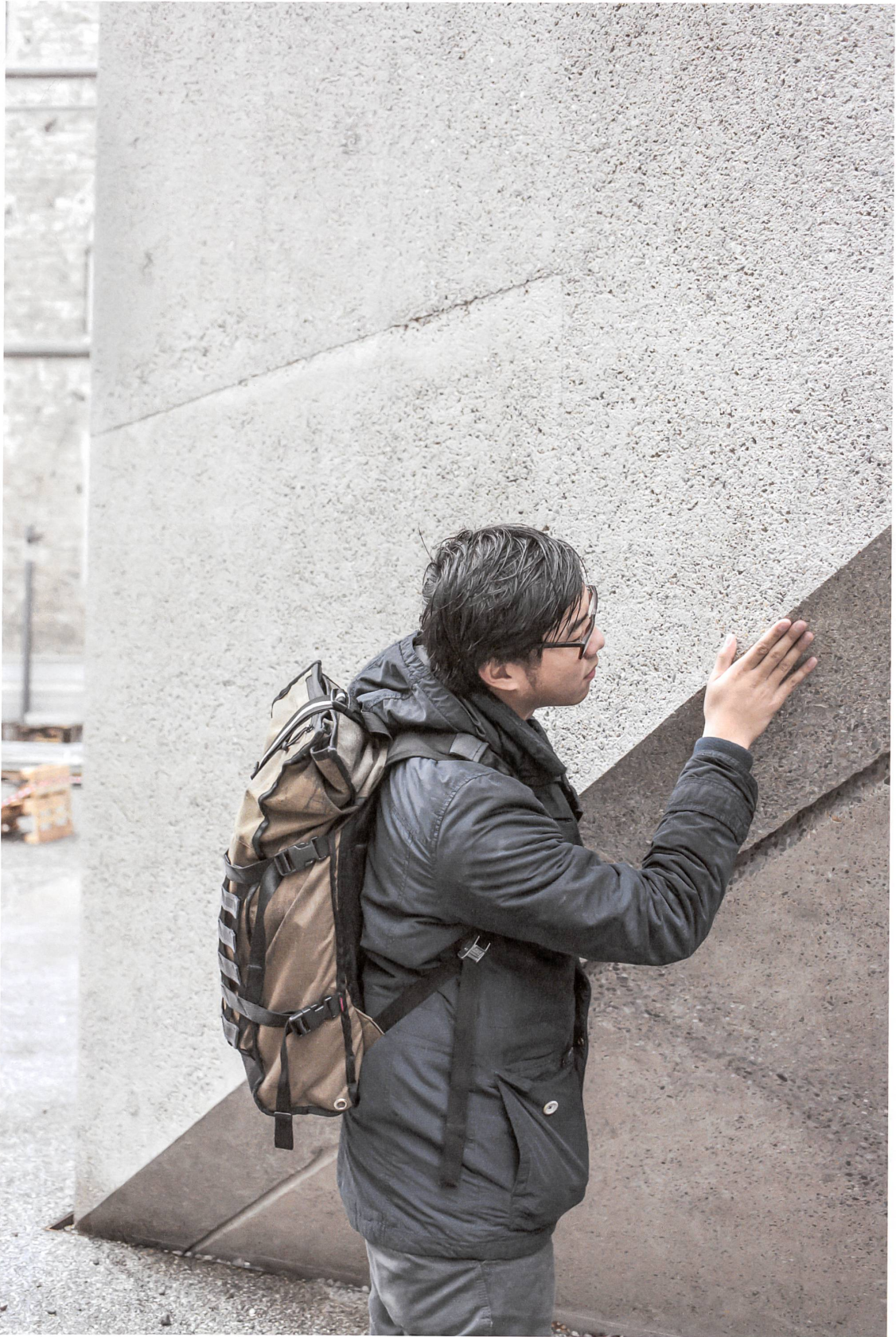
Der Beton mit Tuffzuschlag sucht die Nähe zum Altbau.
