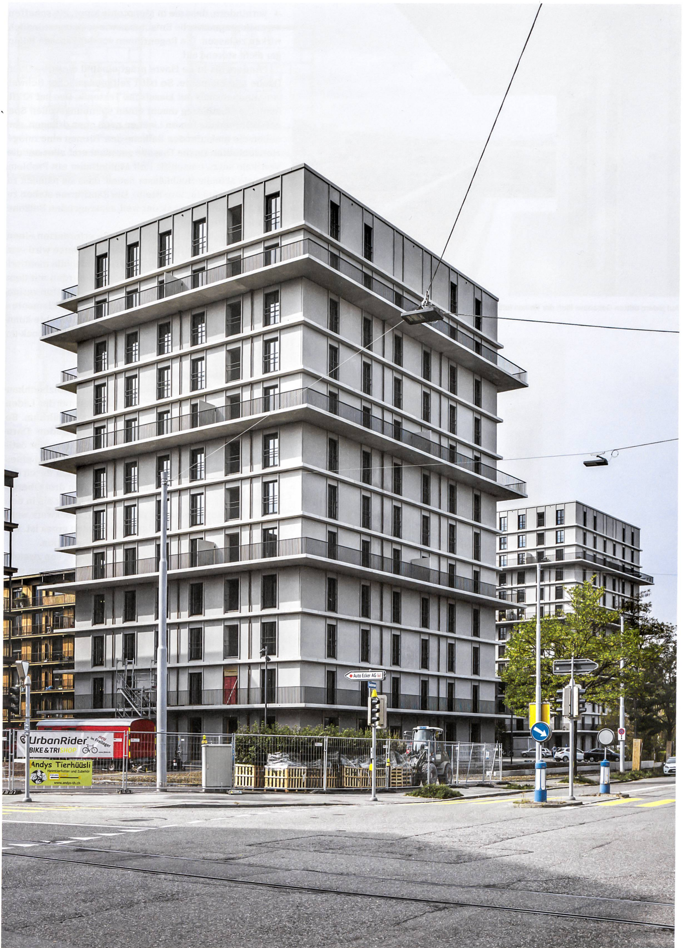
Mit strenger Betonsymmetrie markieren die Rauttürme den Auftakt zum Freilager.
