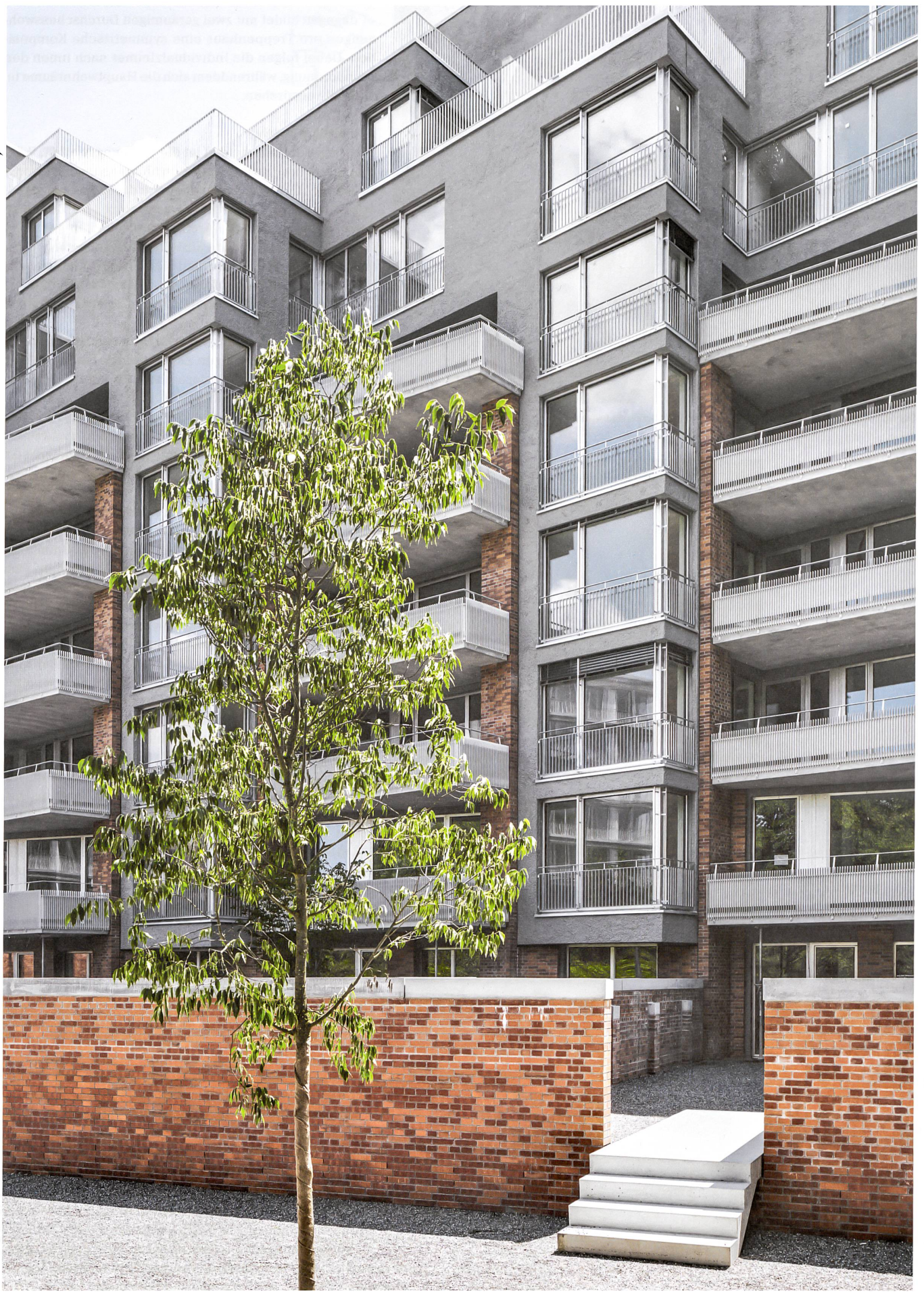
Wie monumentale Sägeblätter fressen sich die achtgeschossigen Zackenzeilen durch den Stadtraum und lenken die Blicke der Bewohner in den Landschaftsraum des Üetlibergs.
