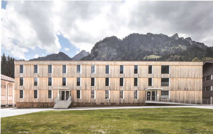
Auf Stützen und mit Weisstanne an den Fassaden: eines von zwei identischen Häusern auf dem Campus Schwarzsee.
