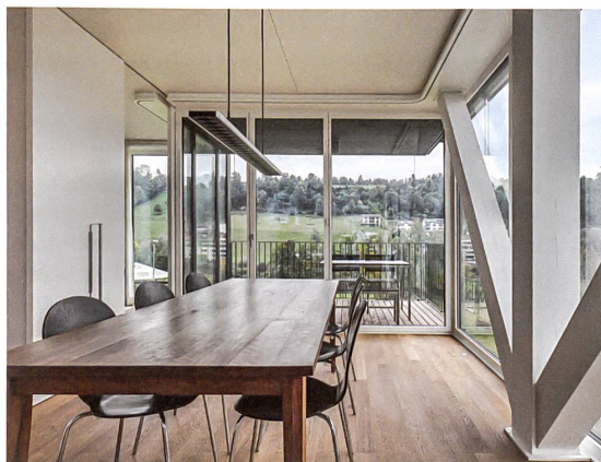
Wie ein Tisch tragen Stützen und Streben das hölzerne Schlafgeschoss.
