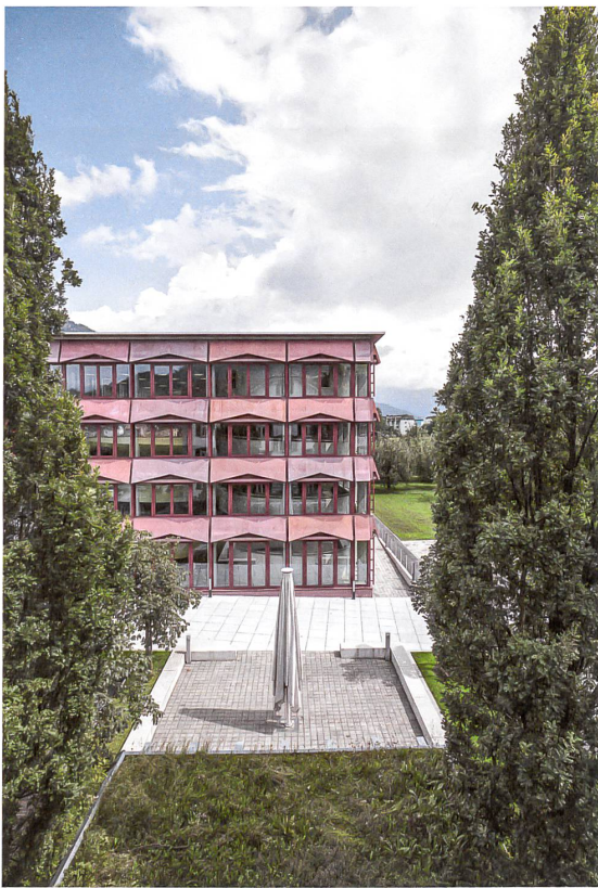
Schräge Betonscheiben an der Fassade der Tagesstätte für Mehrfachbeeinträchtigte in Stans.
