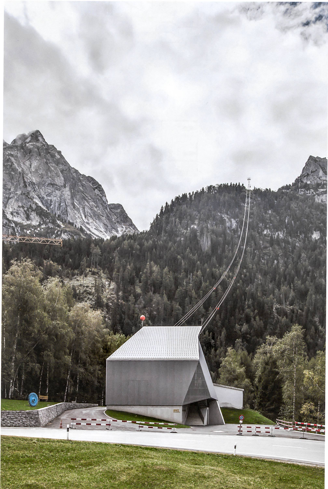
Die Werkseilbahn Albigna im Bergell lockt auch Touristen an. Über die Eingangstreppe haben die Architekten einen Wellblechmantel gefaltet.
