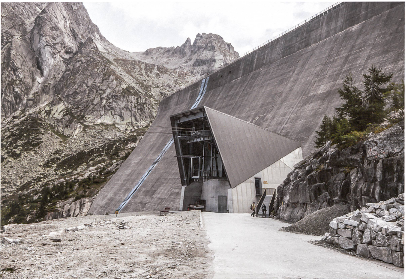
Die Bergstation ist körperhafter und grösser, vor der Albigna-Staumauer wirkt sie dennoch winzig.
