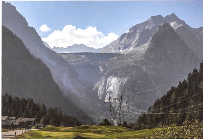
Strom für die Stadt Zürich: Die Albigna-Staumauer sitzt wie ein Wellenbrecher im Felsenmeer.
