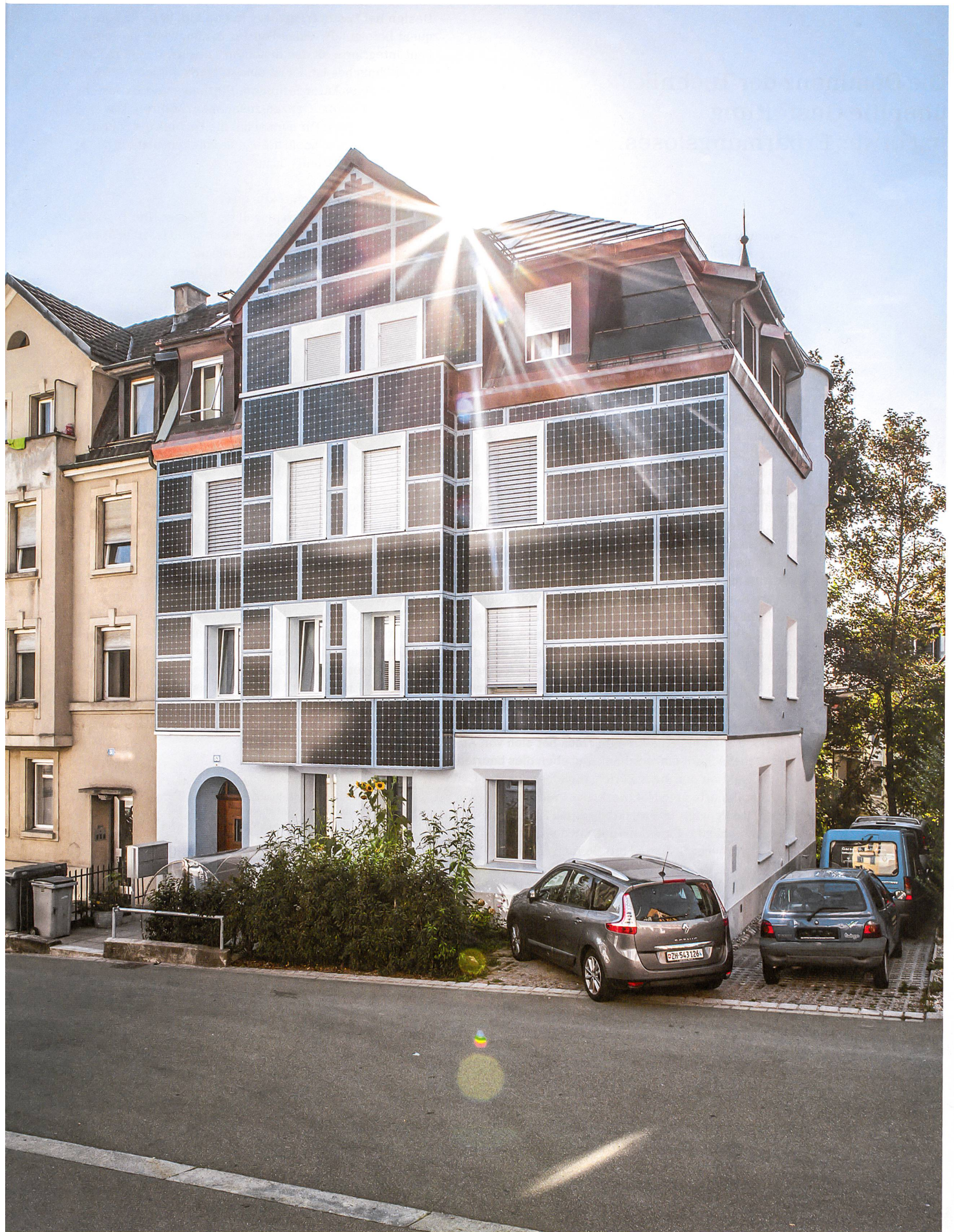
Vor der Sanierung sah das rechte Haus noch aus wie jenes links daneben. Dann wurde es zu einem Statement für die solare Zukunft.
