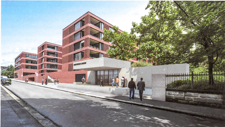
Vom Auditorium des Careums in Zürich ist nur der Eingang zu sehen. Die restlichen Räume liegen unter dem Boden.
