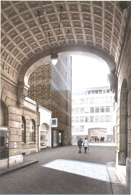
Die reich gezeichneten Fassaden passen gut zum Standort in der Basler Altstadt.
