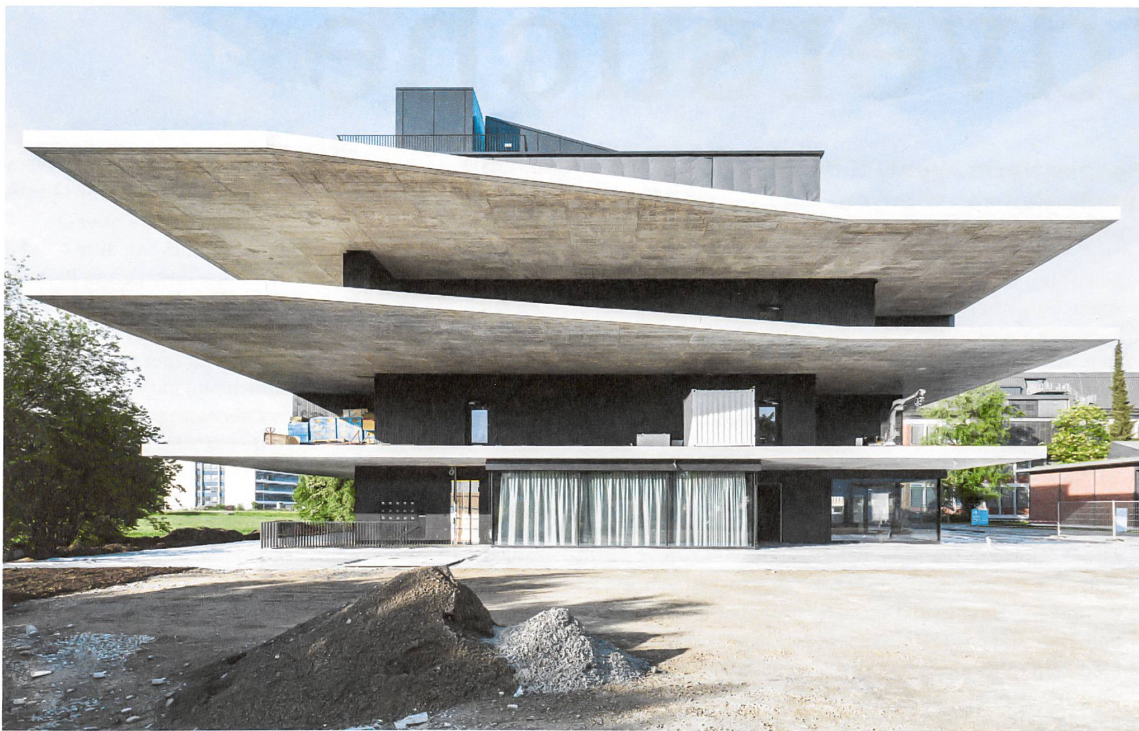
Weit kragt das Betongerüst des Versuchshauses aus, in das die Forschungsmodule eingeschoben werden.
