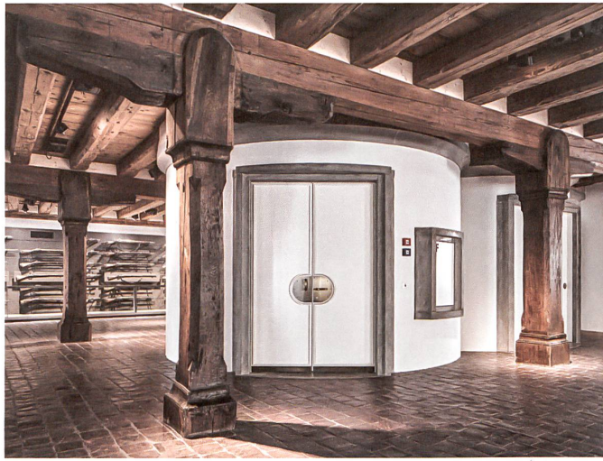
Der neue Erschliessungskern im Solothurner Zeughaus «klont» das alte Treppenhaus.
