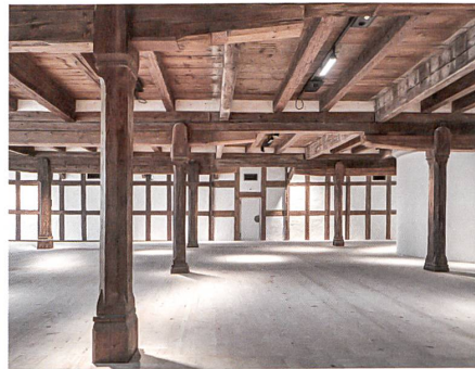
Die technische und statische Aufrüstung liegt im Hohlraum über der alten Decke verborgen.
