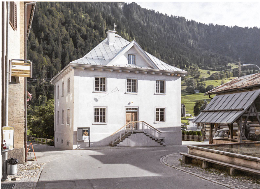
Das alte Schulhaus am Dorfplatz von Valendas dient nun als Besucherzentrum des nahen Naturparks Beverin.
