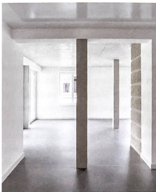
Der Terrazzoboden fliesst vom Altbau in den Neubau. Die Pfeiler definieren den Raum, die spiegelnde Decke erweitert ihn.
