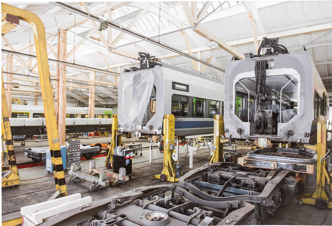
Reinigen, warten, reparieren: Das Berner Bahnunternehmen BLS sucht einen zentralen Standort als Ersatz für die Werkstätte Bern-Aebimatt.
