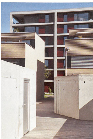
Der Weg schneidet scharf durch die Reihenhäuser auf dem Baufeld D.
